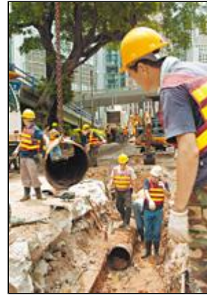
工人忙於搶修爆裂的水管。
